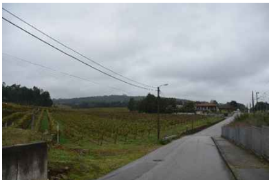
X9 Rua António Pereira Araújo Fonseca, futuro acesso a beneficiar, até ao entroncamento com a Rua das Sete Fontes (ao fundo), adjacente ao Terminal Ferroviário - área administrativa de projeto
