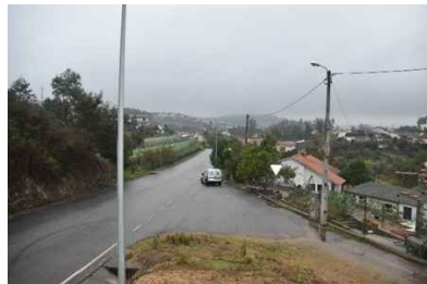
X11 Estrada paralela à linha ferroviária no cruzamento com a Rua do Folão, no troço onde surgirão as novas linhas para o lado esquerdo desta via
