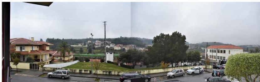
X14 Rua dos Vicentinos, com visualização para a linha ferroviária, no troço onde surgirão novas linhas no lado oposto ao da barreira acústica, ao desta visualização
